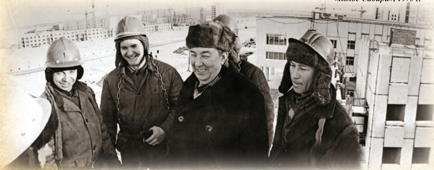
Академик И.И. Сиягин на строительной площадке ВАСХНИЛ-городка
